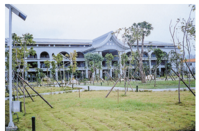
板橋志工中心
