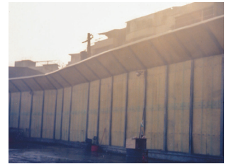
台汽客運 - 隔音牆工程
