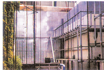
宏邑開發 - 隔音工程
