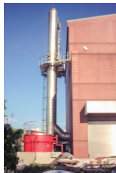
高雄小港流體化焚化爐
