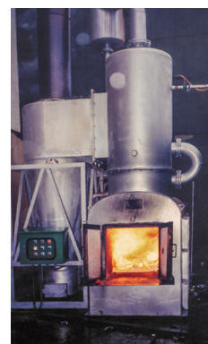
定遠染整廠焚化爐工程
