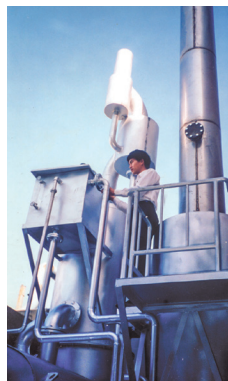
定遠染整廠焚化爐工程
